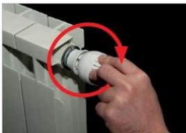
Chiudere a fondo la testa ruotando la manopola (portare la manopola in posizione \*).
