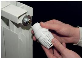
Per installare le teste termostatiche sul corpo valvola, procedere come segue:
