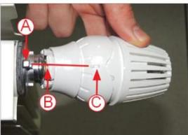
Agganciare la testa termostatica alla valvola, verificando che piolo della valvola (A), feritoia piccola della testa termostatica (B), simbolo Keymark (C), siano allineati. La feritoria corretta per il montaggio è quella più piccola. Non cercare di installare utilizzando la feritoria più grande
